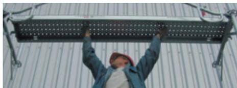
Le montage des planchers s'effectue depuis le niveau inférieur une fois les garde-corps installés. Les poignées assurent une bonne prise en main du plancher.
