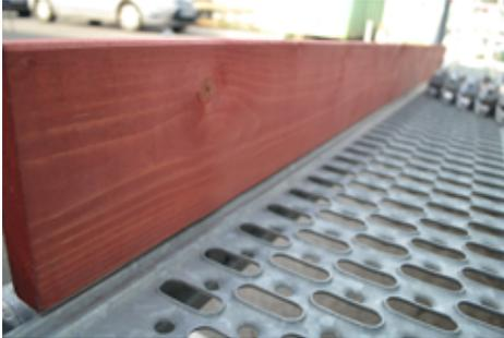
Montage d'un plinthe en bois dans les fentes du plancher.
