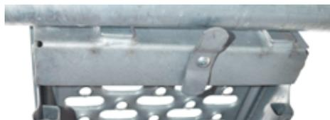
La mise en place de l'anti-soulevement s'effectue par le dessous du plancher. Soit par papillon tournant, soit par tige, selon les types de planchers. La tige se bloque sous le tube supportant le plancher, par gravité.
